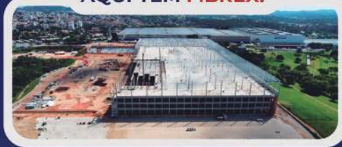
OBRA DE 90.000 m2, EM CONTAGEM (MG).
